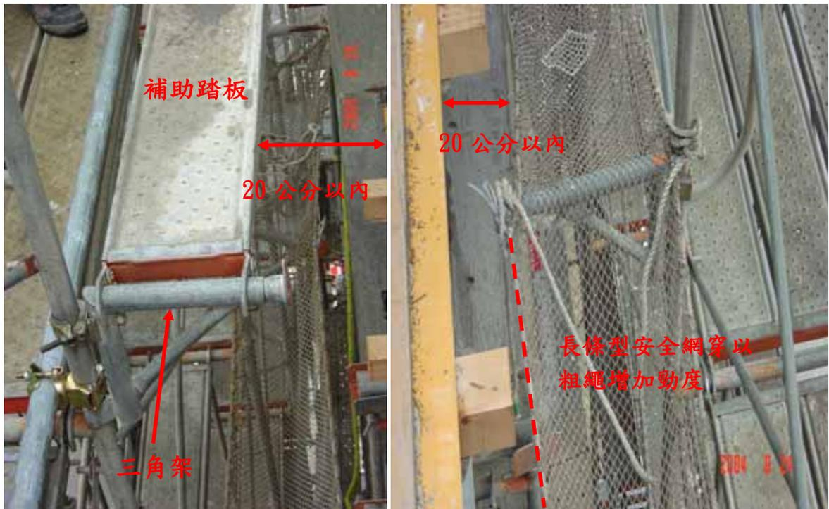
照片 2. 外牆作業時，施工架與結構體間使用三角架鋪設補助踏板或長條型安全網。
