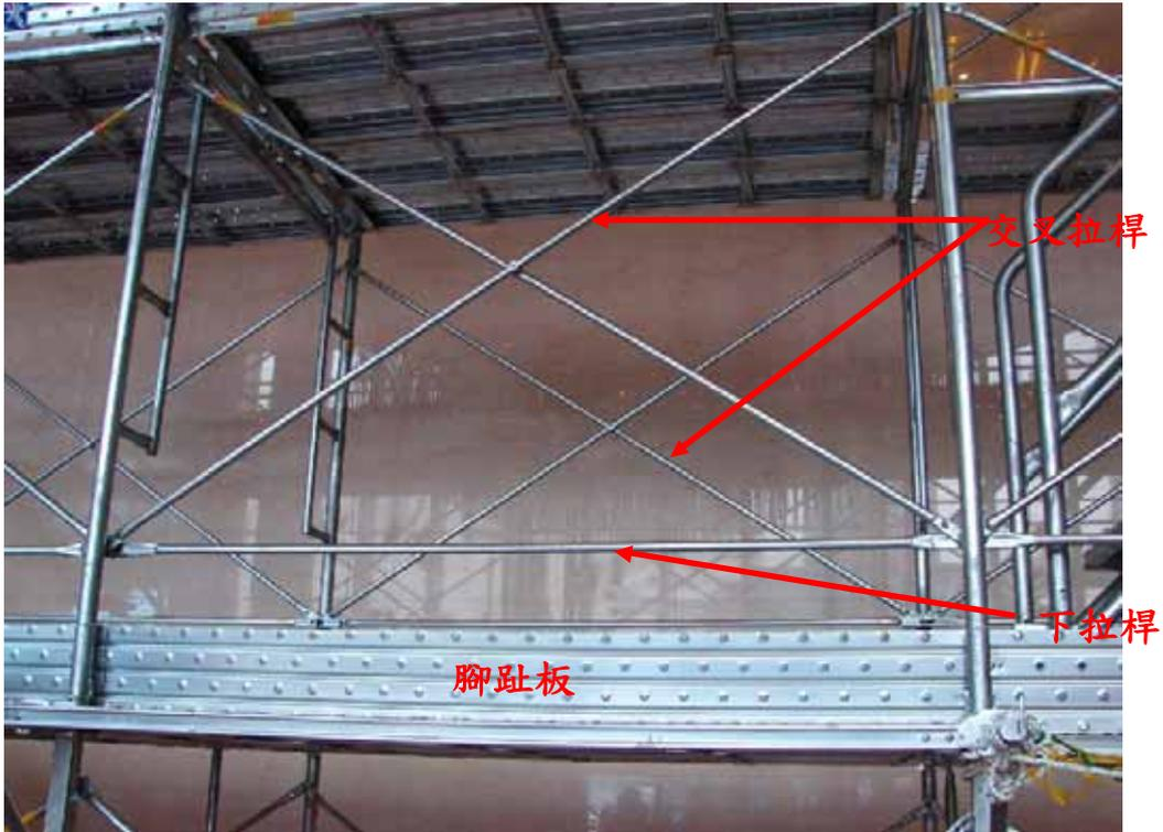
照片 1. 施工架（鷹架）當通道時兩側設置交叉拉桿，下方設置下拉桿。
